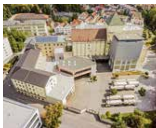
Sandwichposition zwischen Erzeugung und Verarbeit- ung – die Meyermühle 25
